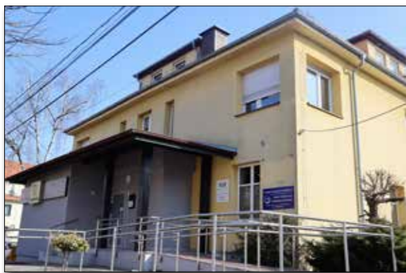
Budynek, w którym mieściła się Izba Porodowa w Czarnowasach, stan obecny
