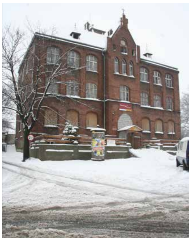
Budynek „starej” szkoły w trakcie przebudowy na hospicjum, 2006 r.
