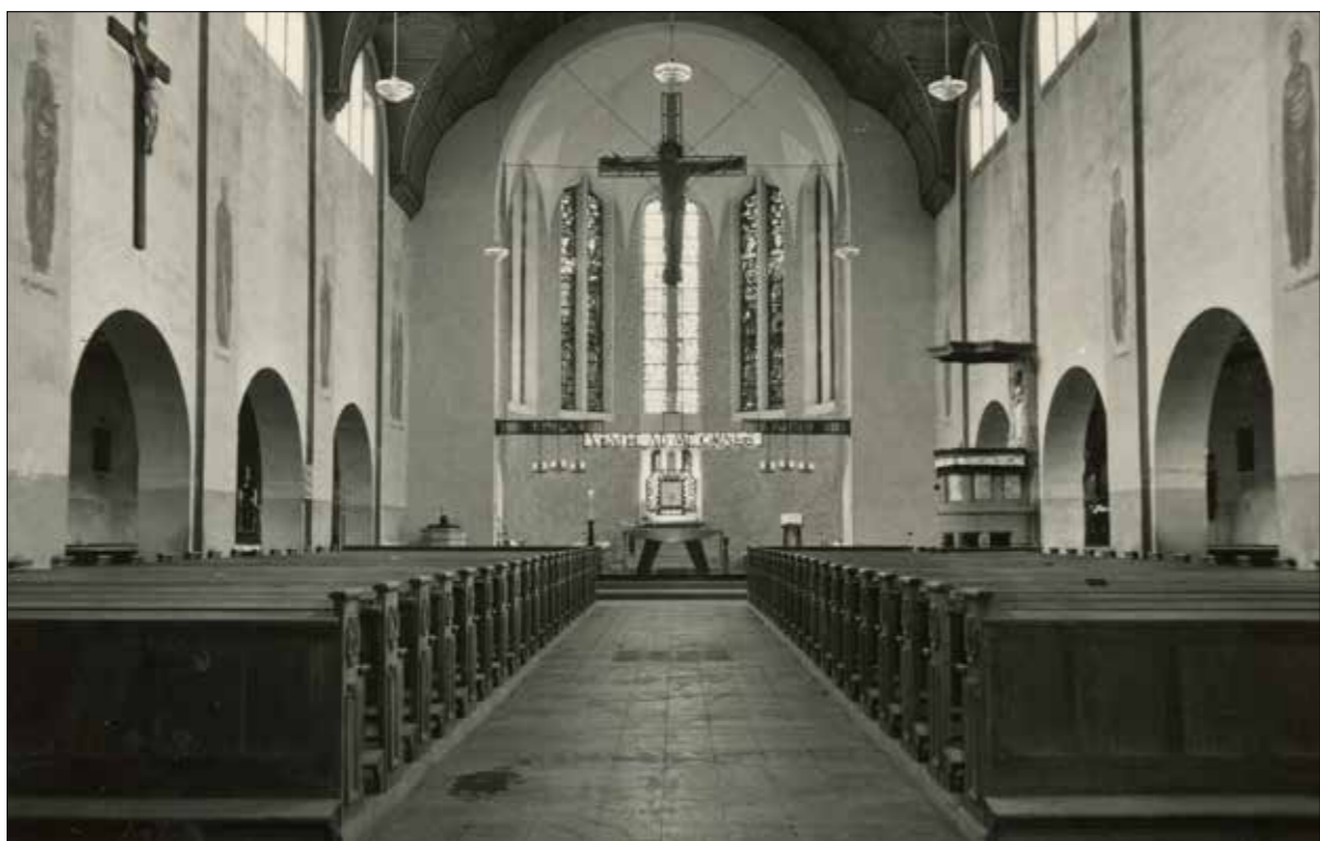
Wnętrze kościoła św. Józefa przed remontem
