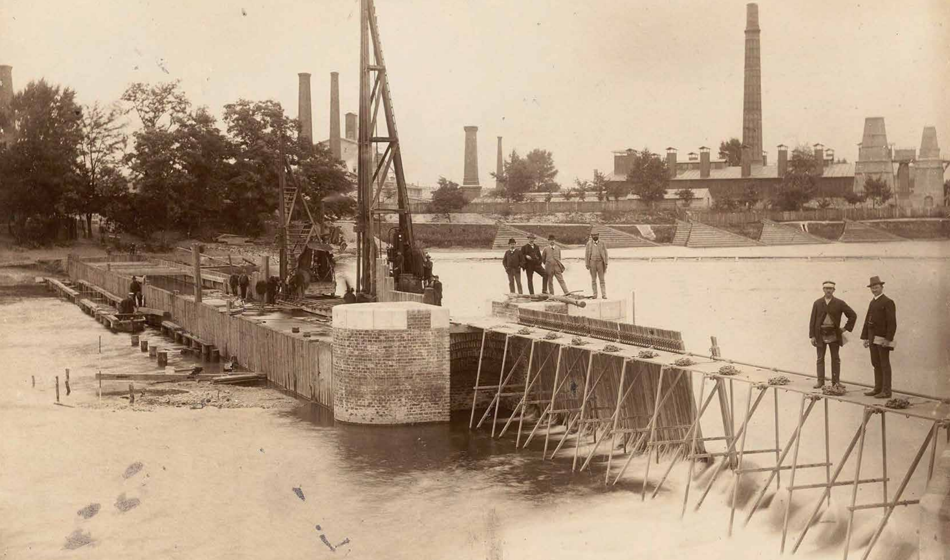
Budowa jazu kozłowo-iglicowego na Odrze, w tle widoczne zabudowania cementowni Grundmanna
